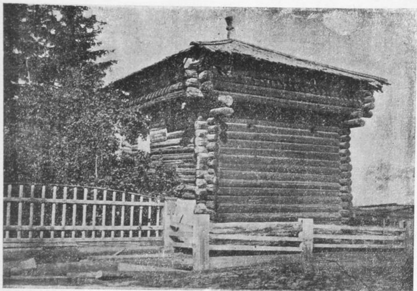
Таб. 3, рис. 12. Южная башня Братского острога (фасад). Фотография инженера Данилова из собрания ВСОРГО.
